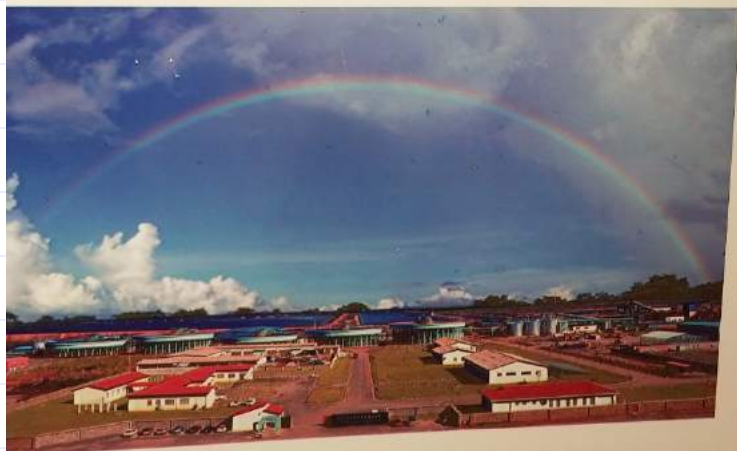
○ 中色卢安夏公司穆里亚希 湿法冶炼厂 The Muliashi Leaching Plant
